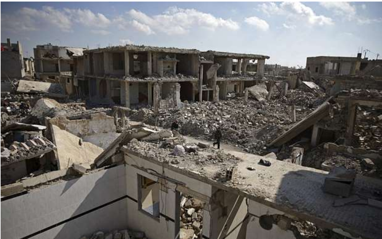
Zerstörte Gebäude in der Douma-Region von Damaskus
